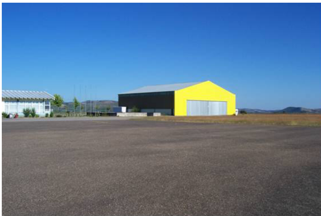
Imagem 3.23. Vista exterior do hangar
